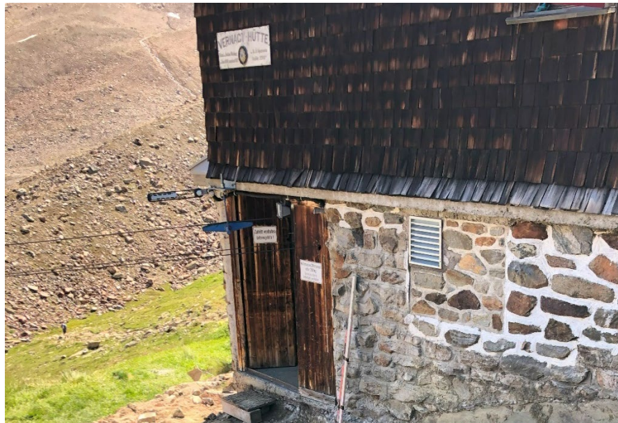
Einfahrt der Materialseilbahn der Vernagthütte
