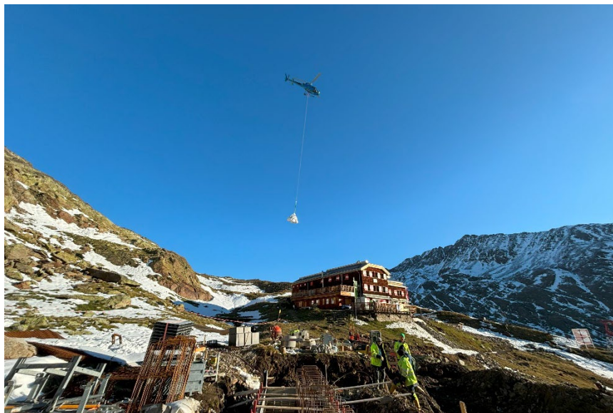
Materialanlieferung auf der Vernagthütte
