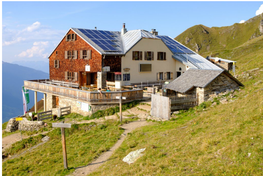
Karl-von-Edel-Hütte mit neuer PV-Anlage
