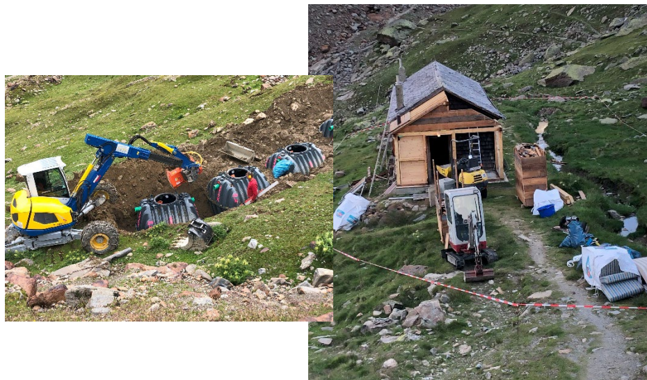
Biologische Kläranlage (links) & Abbruch Winterlager (rechts)
