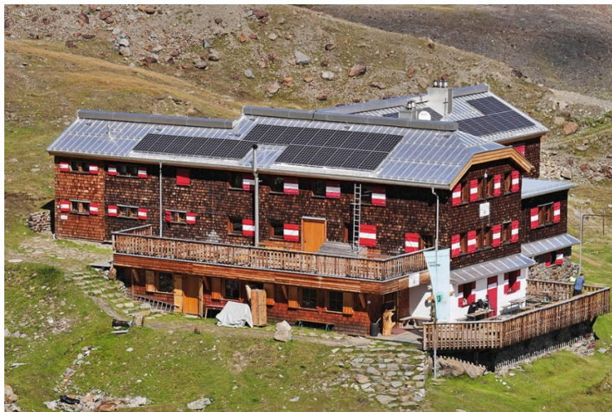
Vernagthütte mit neuem Dach vor der Generalsanierung
