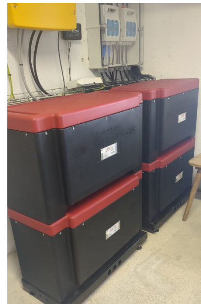
Installation der erweiterten PV-Anlage und neuen Batterieanlage auf der Karl-von-Edel-Hütte
