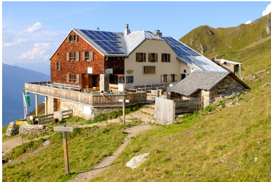
Karl-von-Edel-Hütte mit neuer PV-Anlage
